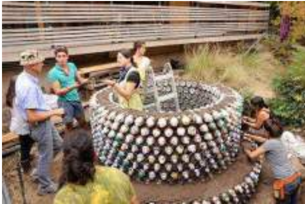
Gambar 6. Batu bata dari limbah plastik
